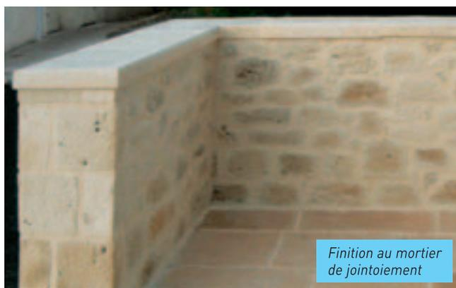
Finition au mortier de jointoiment
