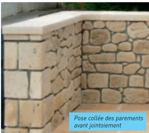
Pose collée des parements avant jointoiment
