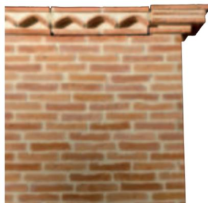
*Exemple de réalisation en parements aspect briques anciennes avec pose d'une gènoise simple et d'un angle sortant*
