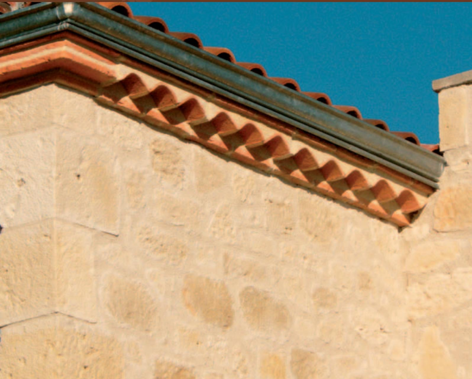
Posée sur l'arase du mur au mortier colle PIERRA, la génoise dispose d'une poignée qui en facilite la manipulation, alors que la butée permet un alignement rapide, les stries offrant une meilleure adhérence au mortier.
