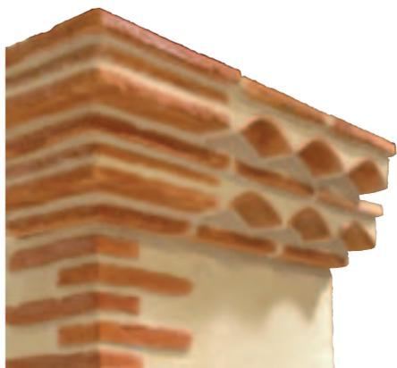
*Exemple de réalisation en double gènoise, version tuileaux avec angles sortants, associée aux parements angles aspect briques anciennes*
